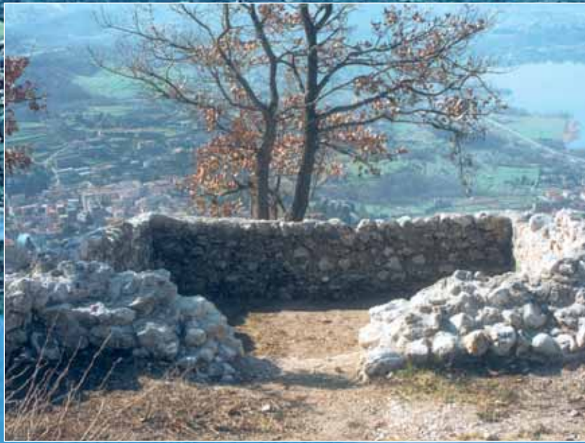
Una torre d'avvistamento lungo il muraioö
