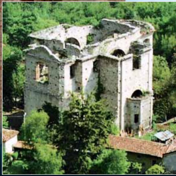
La Chiesa prima del restauro.
